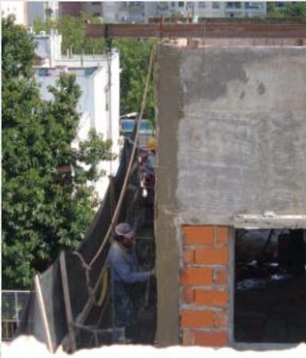
Medianera izquierda Revoque medianeras
