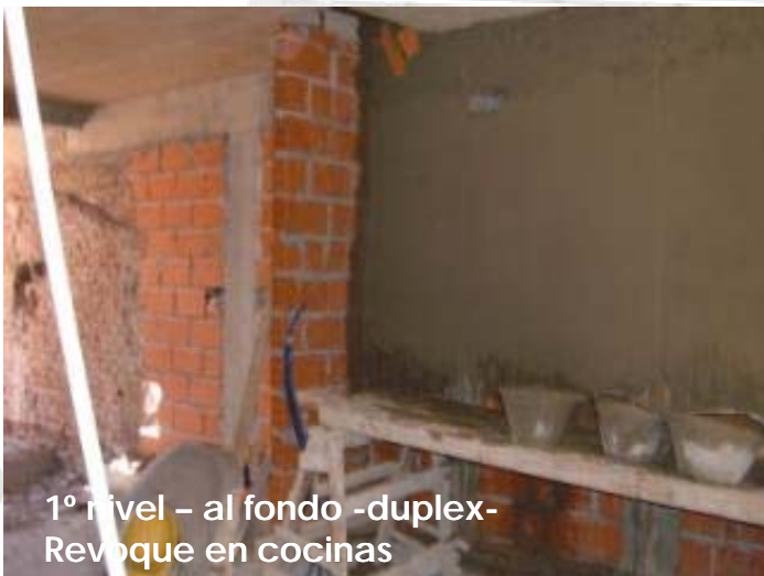
1° nivel - al fondo -duplex- Revoque en cocinas
